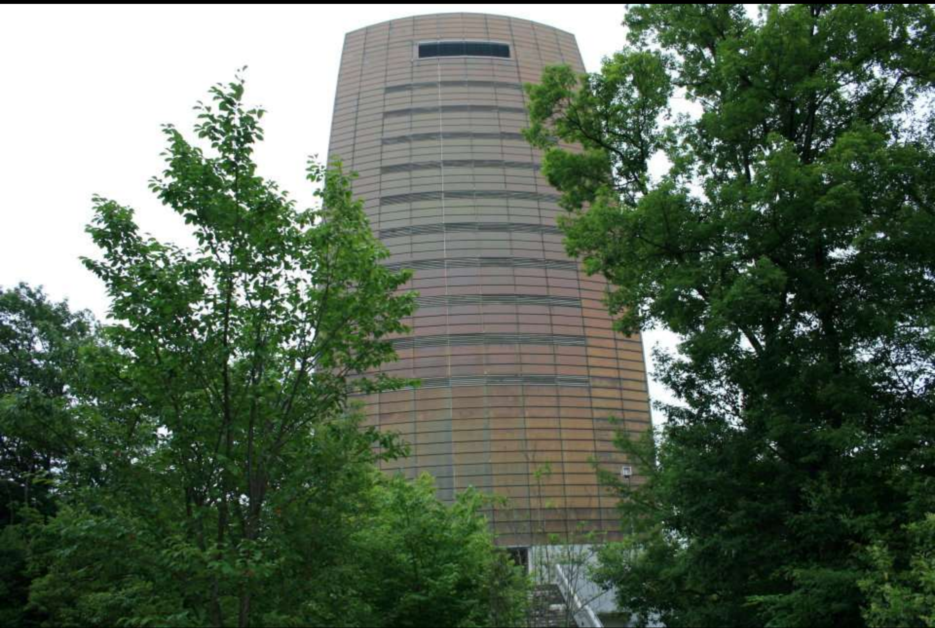
「アクアタワー」 丘陵地帯にある千種区平和公園から東山公園への給水のため、水を一旦上げて自然流下で配水する
